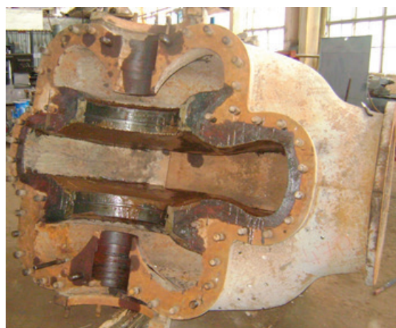
Рис. 4. Полимерное покрытие внутренней поверхности корпуса
